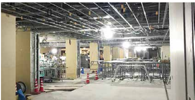
内装工事の状況(1階)
