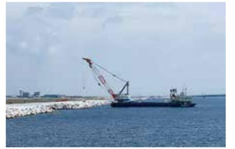
関西国際空港では、2018年9月に発生した台風21号の浸水被害を受け、防災対策の一環として、1期島の護岸嵩上げや消波ブロック設置などの越波対策を進めてきました。今年4月に護岸嵩上げ工事が完了し、10月末には消波ブロックの設置が完了予定です。関西エアポートは、防災機能をより強化し、お客さまに安全・安心にご利用いただける「災害に強い空港」をめざします。
