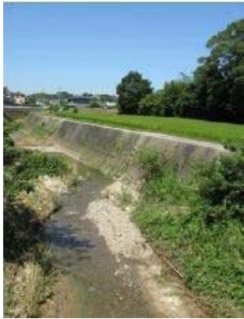
中流 谷川橋付近
