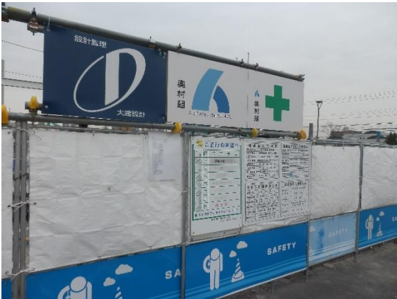
写真2：外部仮囲い掲示状況
