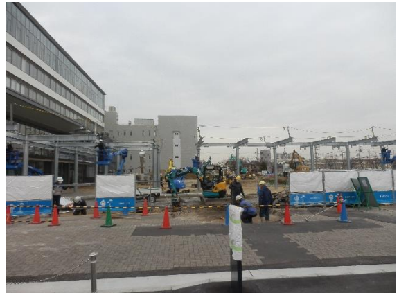
写真3：外構工事状況
