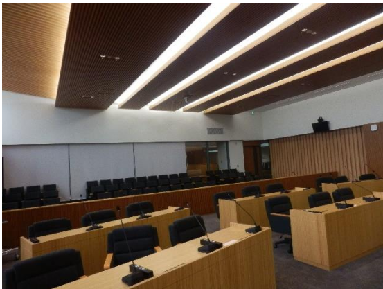
写真4：議場仕上り状況
