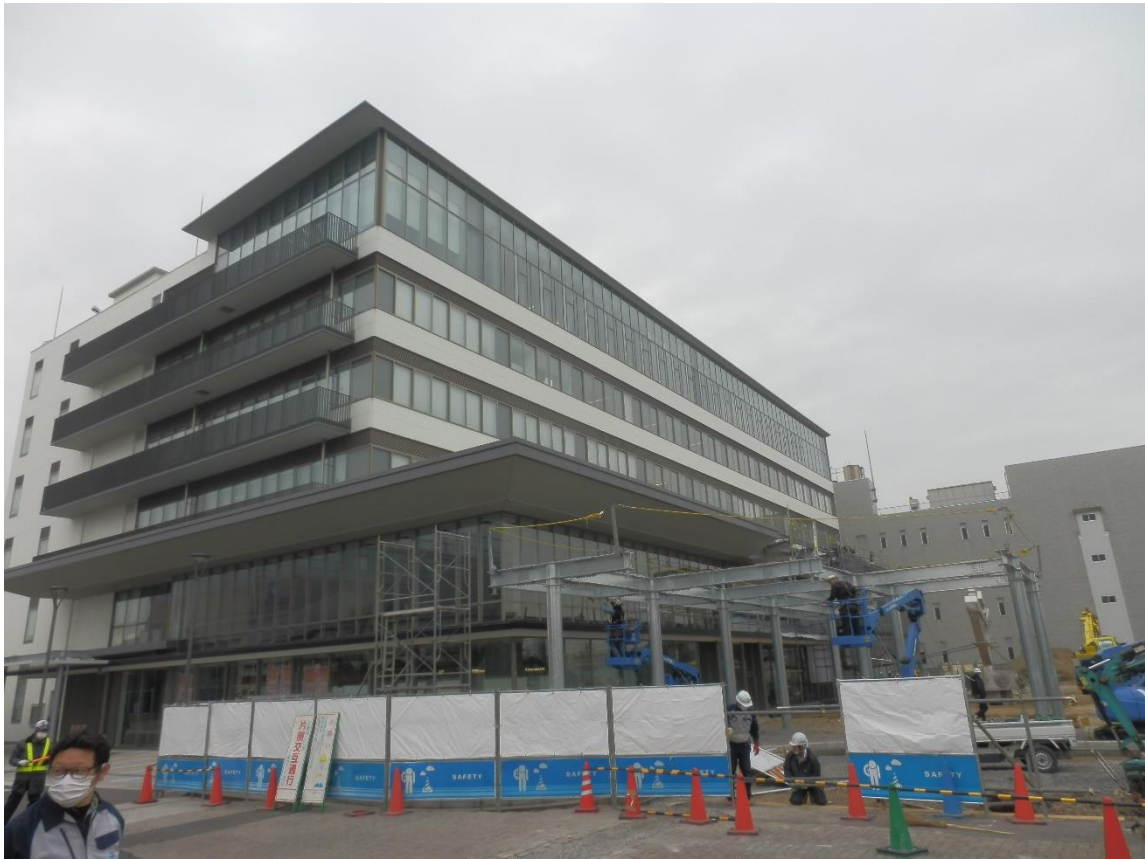
写真1：監査当日の現場外観写真
