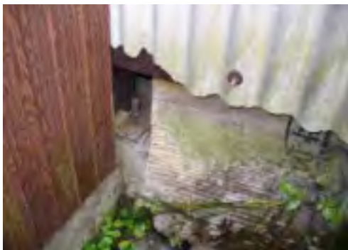
家屋への侵入口 (毛や泥が付着する、爪痕が残る場合がある)
