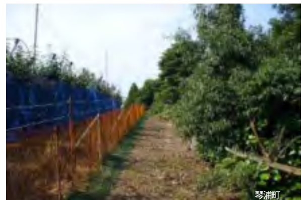
電気柵とワイヤーメッシュ柵の複合柵 上部 電気柵 下部 ワイヤーメッシュ柵
