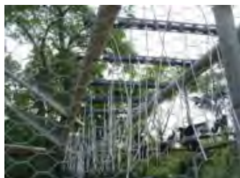
捕獲オリの入り口の構造 入ったカラスが外に出ないように、 番線を逆V字にぶら下げる。
