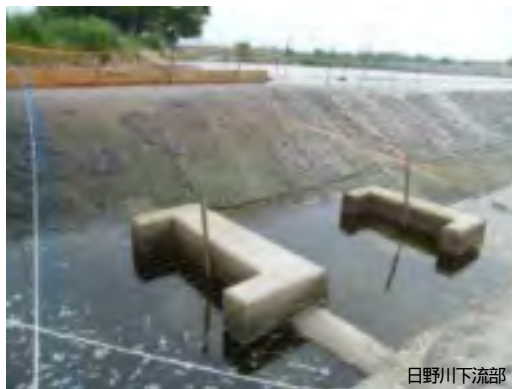
ネット張りによる飛来防止
