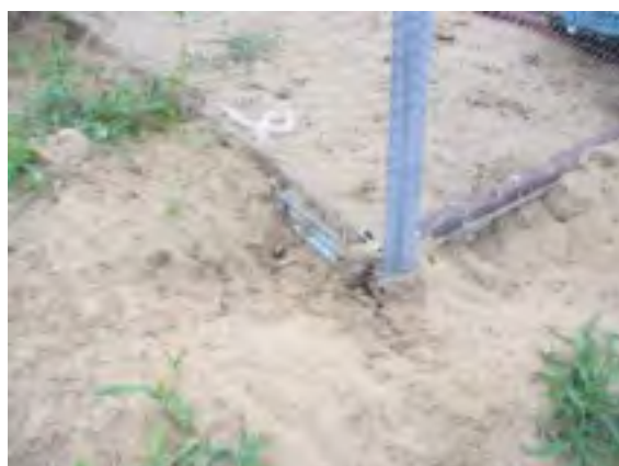
掘り起し防止のためのトタン板 キツネやノイヌ等の侵入を防ぐため、 オリの下部にトタン等の板を埋め込む。
