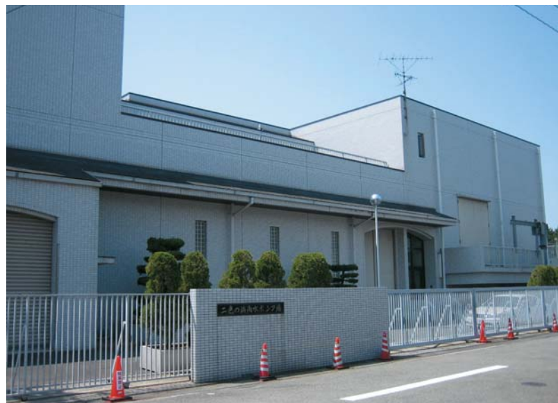
二色の浜雨水ポンプ場
