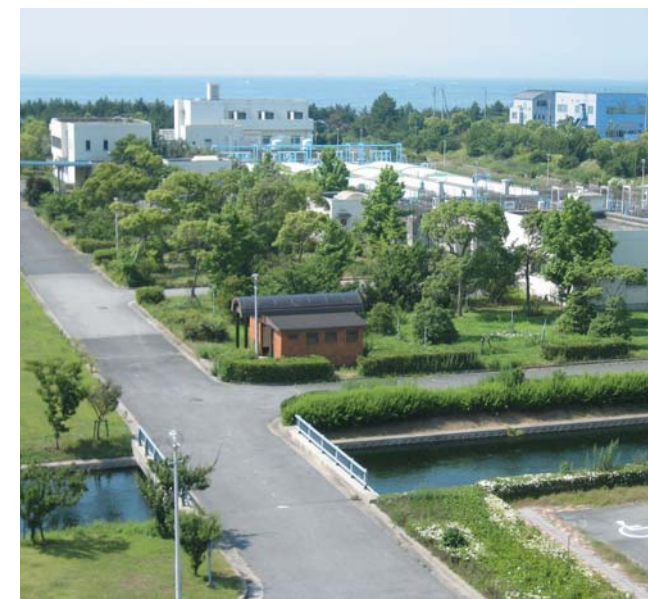
南大阪湾流域下水道 中部水みらいセンター
